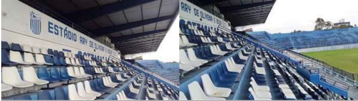
Área interna do Imóvel – Campo e Arquincada Cativa
