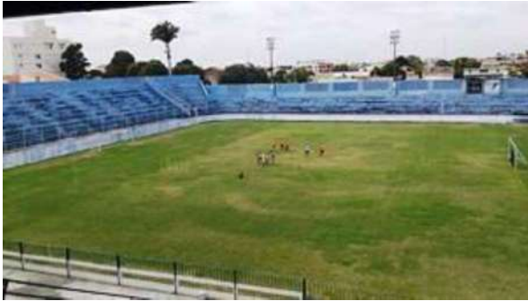
Área interna do Imóvel – Campo e Arquincada
