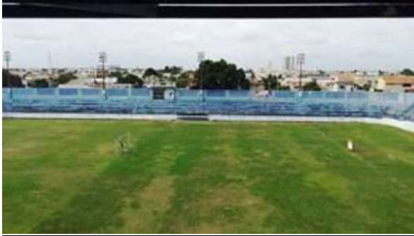
Área interna do Imóvel – Campo e Arquincada
