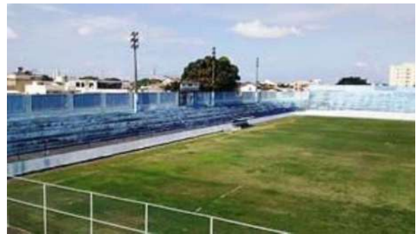
Área externa do Imóvel – Visão das Arquibancadas
