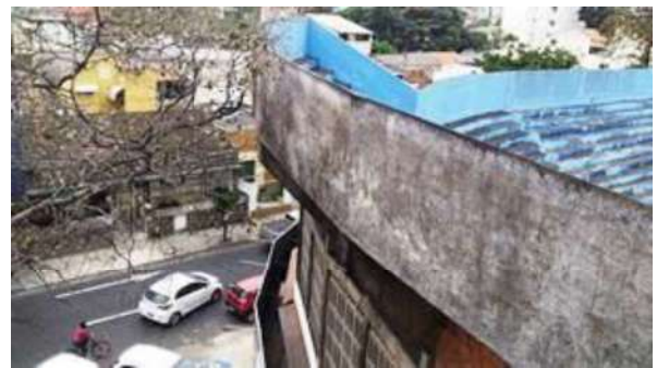
Área externa do Imóvel – Visão das Arquibancadas
