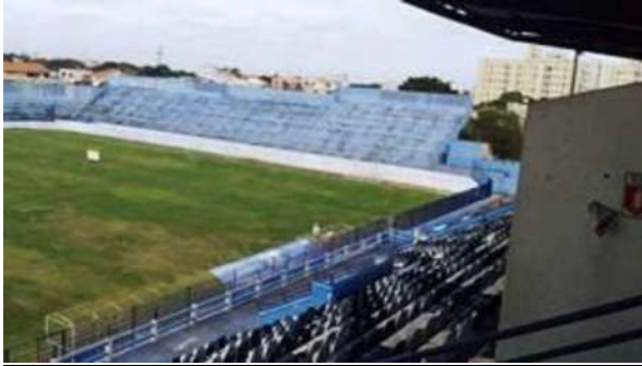
Área interna do Imóvel – Campo e Arquincadas
